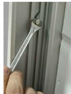
6- Serrer les vis progressivement sur chaque montant et traverses avec une clé de 8 mm.
