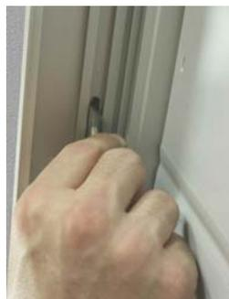
5- Positionner les inserts avec les vis face aux trous prévus dans les rainures du cadre de l'appareil.
