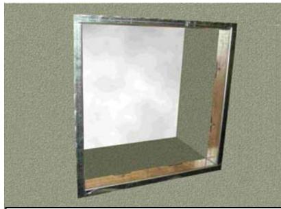
2- Vérifier que le pré-cadre scellé précédemment soit parfaitement nettoyé de toutes saletés ou coulures de ciment..., et présenter l'appareil dans le pré-cadre en s'assurant de son équerrage et de sa planéité
