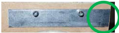
6. Percer le vantail en utilisant le rail de guidage comme gabarit avec un foret Ø5mm
