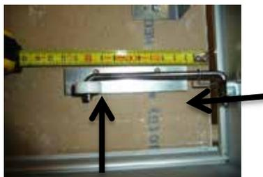
7. Percer le vantail en utilisant le rail de guidage comme gabarit avec un foret Ø5mm
