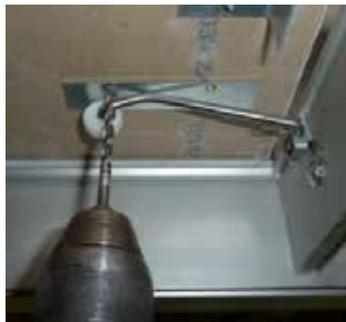
8. Riveter le rail de guidage sur le vantail avec le rivet L47 + rondelle au dos du vantail.
