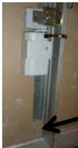
b) Positionner le sélecteur de vantail en fond de rainure du montant intermédiaire.
