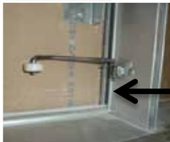
c) Contre percer le montant intermédiaire à l'aide d'un foret Ø5mm
