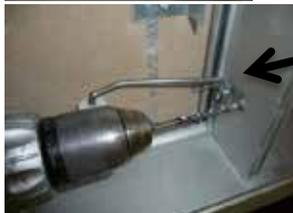
5. Fixer le sélecteur de vantail avec la vis + écrou Ø5
